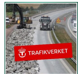
Peter Alfredsson & Mats Persson Trafikverket Betongvägar
